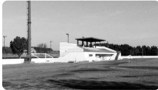
串良町の陸上競技場
