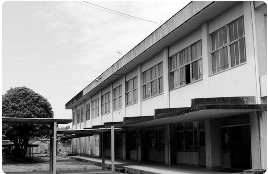
大規模改造が予定されている特別教室棟（大崎中学校）
