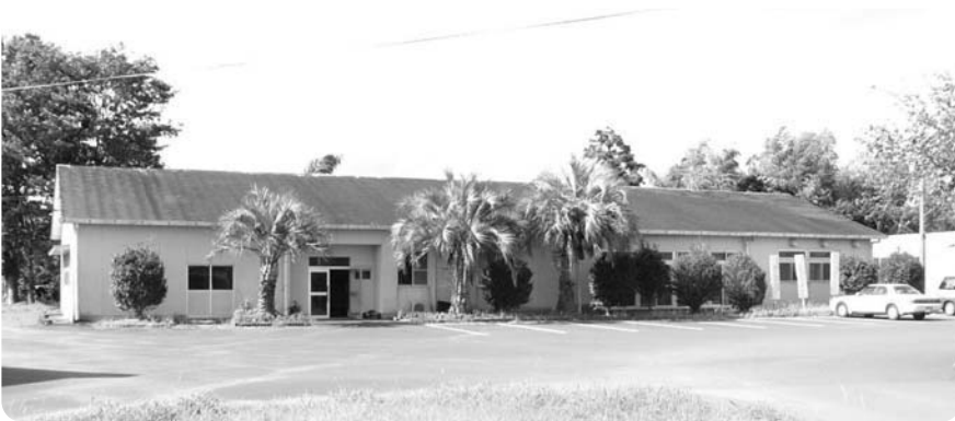
改修予定の農業研修館
