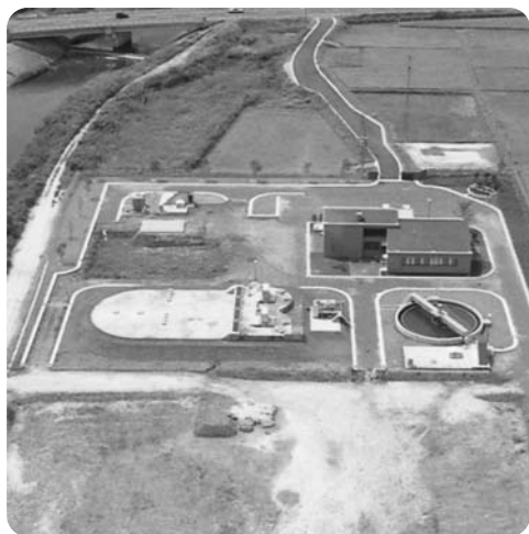
上空から見たクリーンセンター
