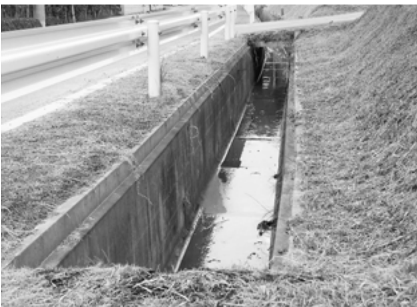
▲シラス対策事業で整備された排水路
