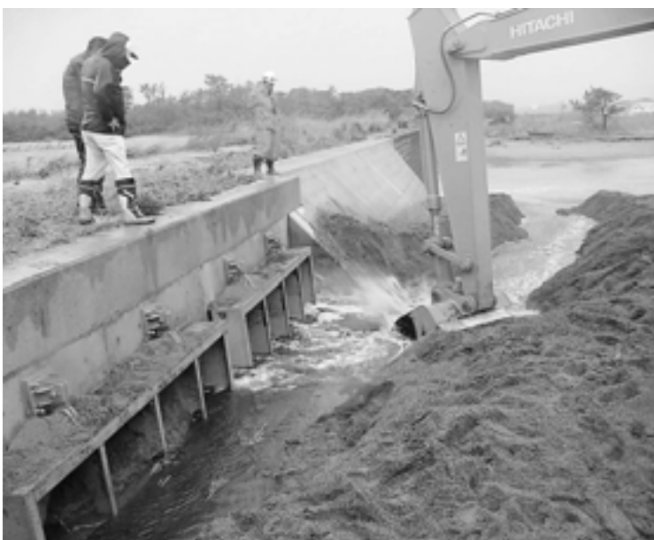
▲樋門の海砂取り除き作業
