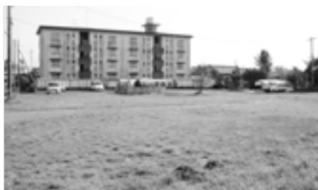
▲放置されている野方地区の町有地
