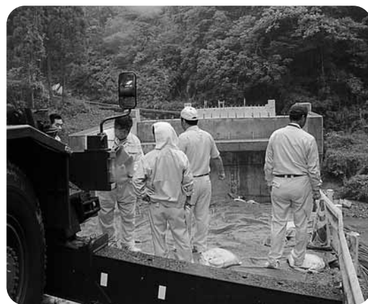
梅ヶ渡橋災害復旧現場
