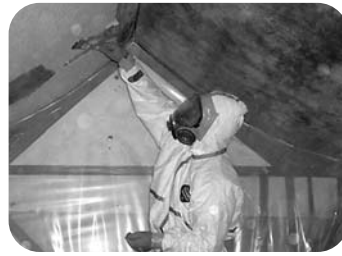
アスベスト除去作業
