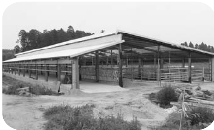
本事業により建設された牛舎
