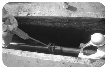
水道管取替え工事
