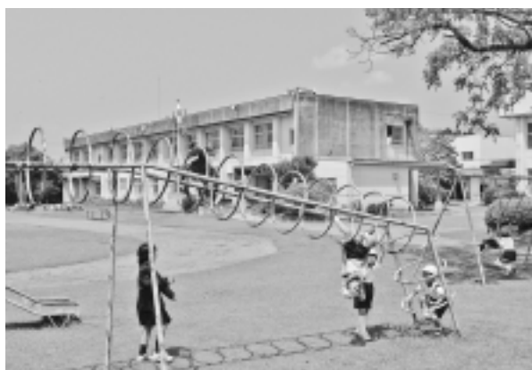
プール改修と校舎屋根防水工事予定の中沖小学校
