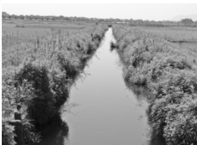
河川維持工事の行われる汐入川
