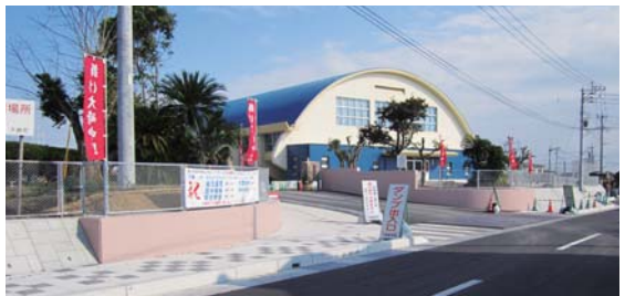
工事中の正門
