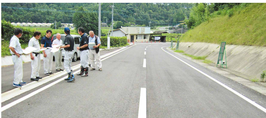
町道井俣～茶ノ木線道路改良工事を調査
