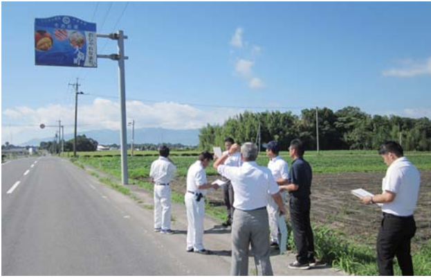
観光案内板設置工事を調査
