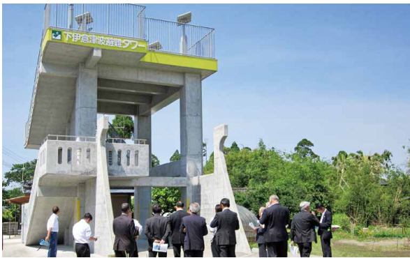
本町にも必要と思われる津波避難タワーを視察
