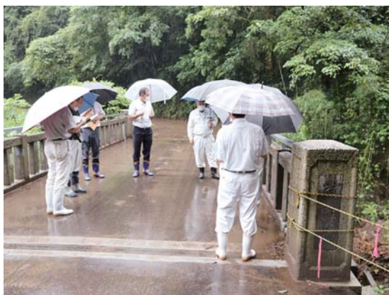
轟橋補修箇所を調査（持留地区）
