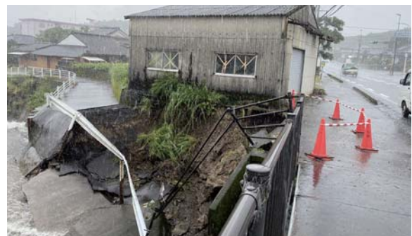
崩落した高尾川の堤防
