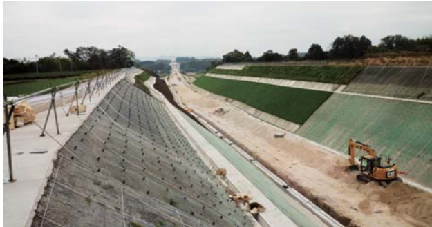
豪雨時に河川への影響が懸念される高速道路
