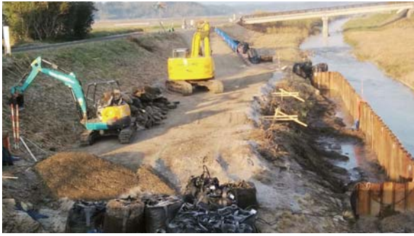
持留川の護岸工事
