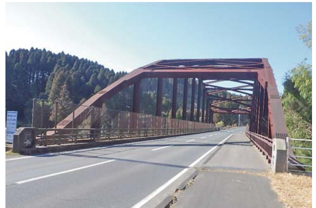
尾迫橋補修工事（過疎対策）
