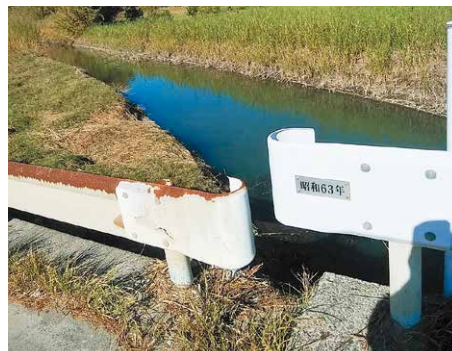
改修完了が待たれる天神川
