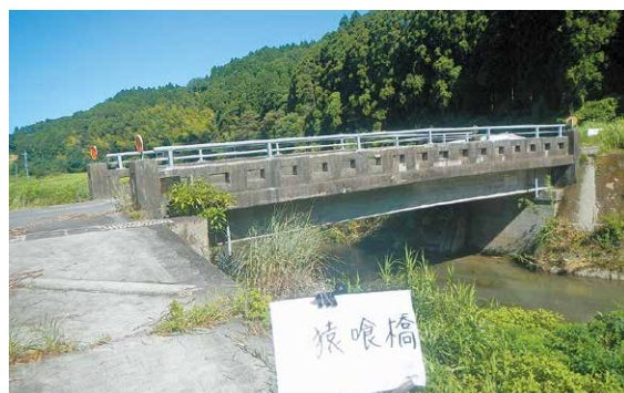
設置後69年の猿喰橋
