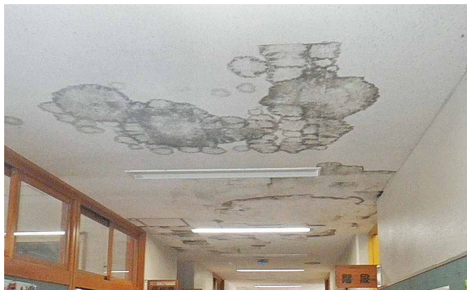
改修予定の廊下天井
