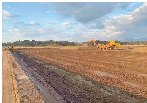
水田区画整備事業（益丸地区）
