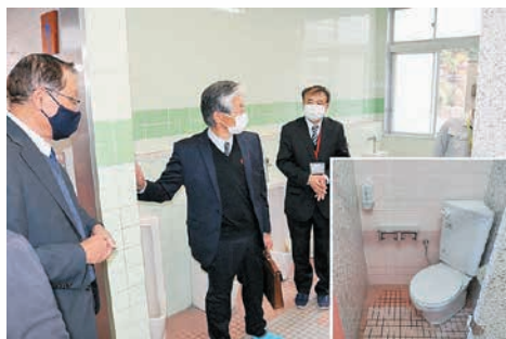
監査の様子 【大崎小学校トイレ洋式化工事】
