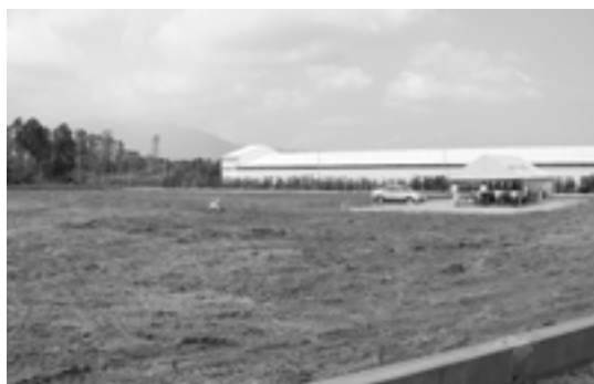
▲野方地内の建設地
