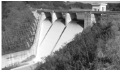
▲輝北ダムは、高さ約42メートル、幅約114メートル、貯水量約635万立方メートルの重力式コンクリートダムとなっています。
