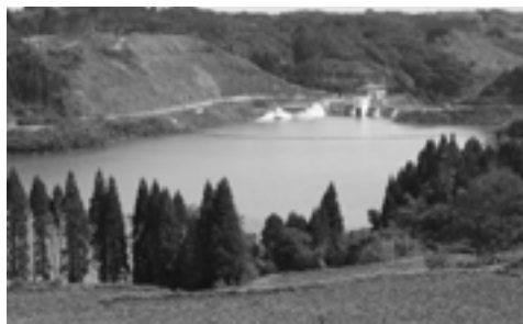
▲ダム本体が完成し、現在湛水試験中。平成18年度末には一部通水を予定しています。
