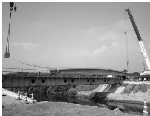
▲天子橋災害復旧工事
