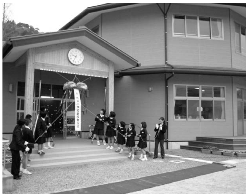
▲持留小学校改築工事
