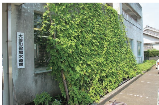
建物内への直射日光を遮断して、気温上昇を抑制する『緑のカーテン』の使用状況。
