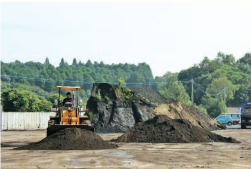
▲搬入された黒土は、使用目的に合わせて川砂や赤土などを混合します。
