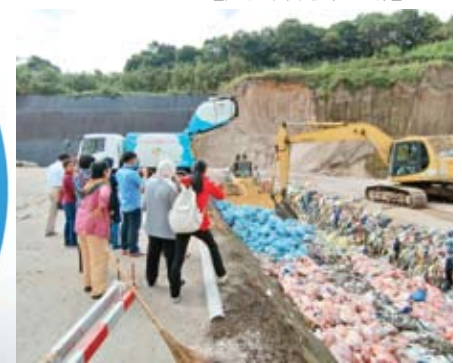
▲埋立処分場の搬入状況 【清掃センター】
