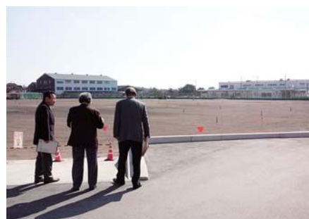
▲大崎中学校屋外運動場整備工事の状況
