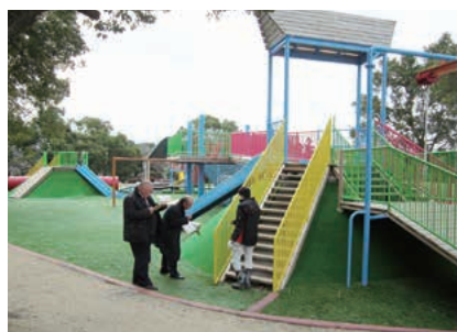
▲ふれあいの里公園遊具施設改修工事
