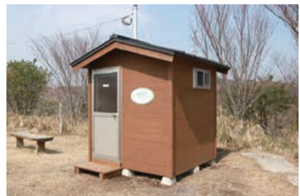
【バイオトイレ外観】
