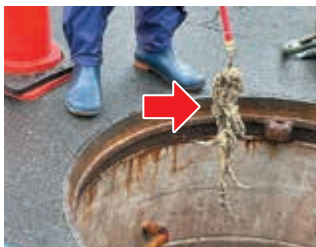
郵便局前MP場1号ポンプ他の故障(不織布、ネジ) ↑ →
